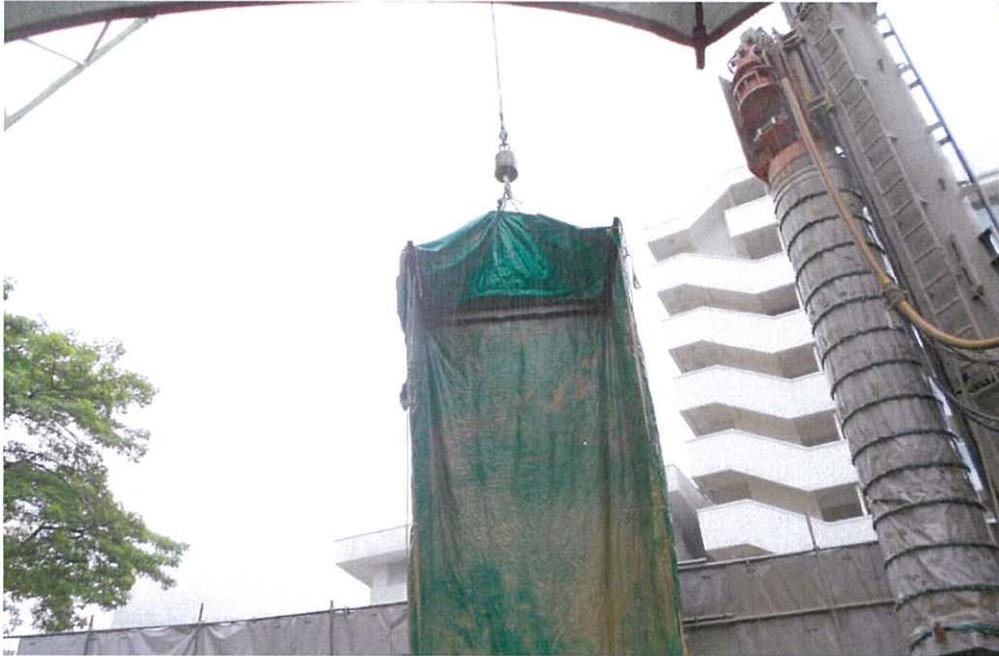
圖一：地面以上的鑽桿及鑽樁機外設置的兩層保護屏障
