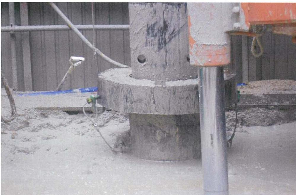
圖二：鋼管接近地面的出口會增設鋼板覆蓋，並以鋼索穩固，大大減低泥漿濺出的機會
